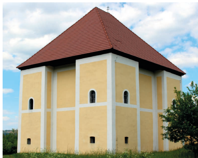
10. Dom Piłata widziany od strony południowego zachodu. Zbliżona do sześcianu bryła budynku w każdym z narożników posiada wzniesioną na planie mniejszego kwadratu wieżę.
