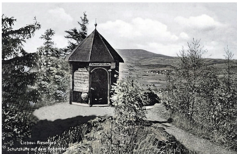
46. Lubawka w Karkonoszach, schron na Kruczej Skale, 710 metrów (warto tu zauważyć, że wysokość tej góry to 681 metrów). Obiekt dziś nie istnieje. Źródło: kreislandeshut.de
