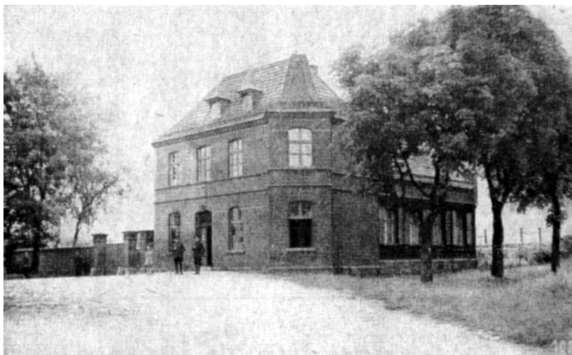
9. Budynek granicznego urzędu celnego w dawnych Jurkowicach. Do dziś jest to ostatni budynek w Lubawce, a więc i w Polsce. Źródło: kreislandeshut.de
