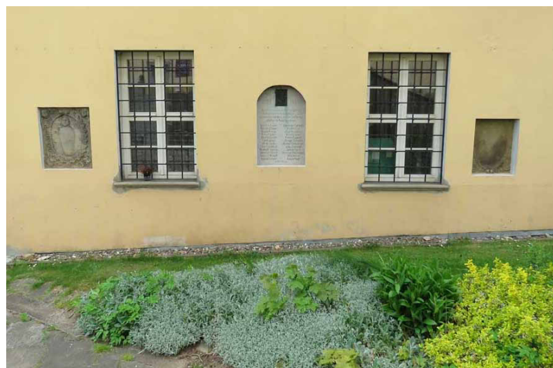
Południowa ściana dawnej plebanii
