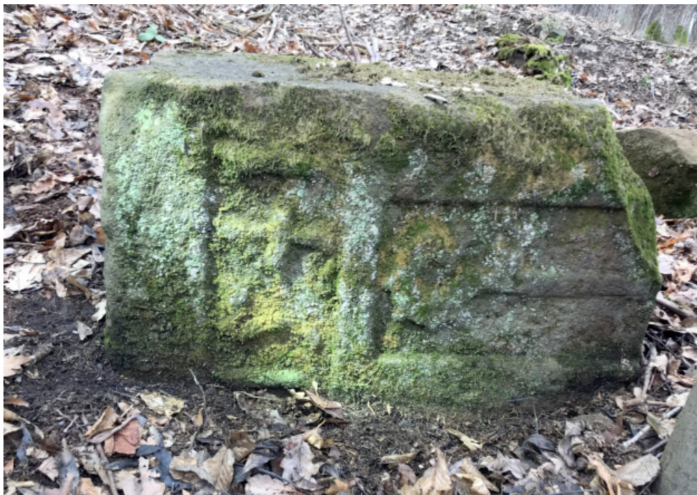
4. Fragment bocznej powierzchni szczytowego elementu uszkodzonego słupa, zlokalizowanego w punkcie A (por. il. 2), fot. M. Gabrowski, luty 2021 r.
