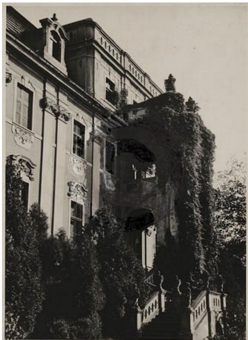
12. Elewacja południowa (ogrodowa); loggia z narożnymi pilastrami oraz pilastry na licu elewacji.
