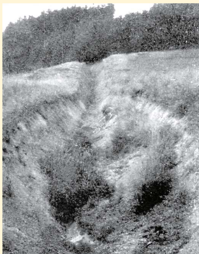
Rów przeciwczołgowy wykopany w okolicach Lubawki przez więźniów AL Landeshut. Źródło: D. Alberski, dz. cyt.
