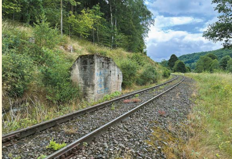
Tory wiodące do Lubawki oraz sąsiadująca z nimi betonowa konstrukcja
